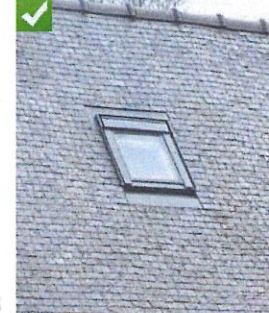
Pose encastrée préconisée
